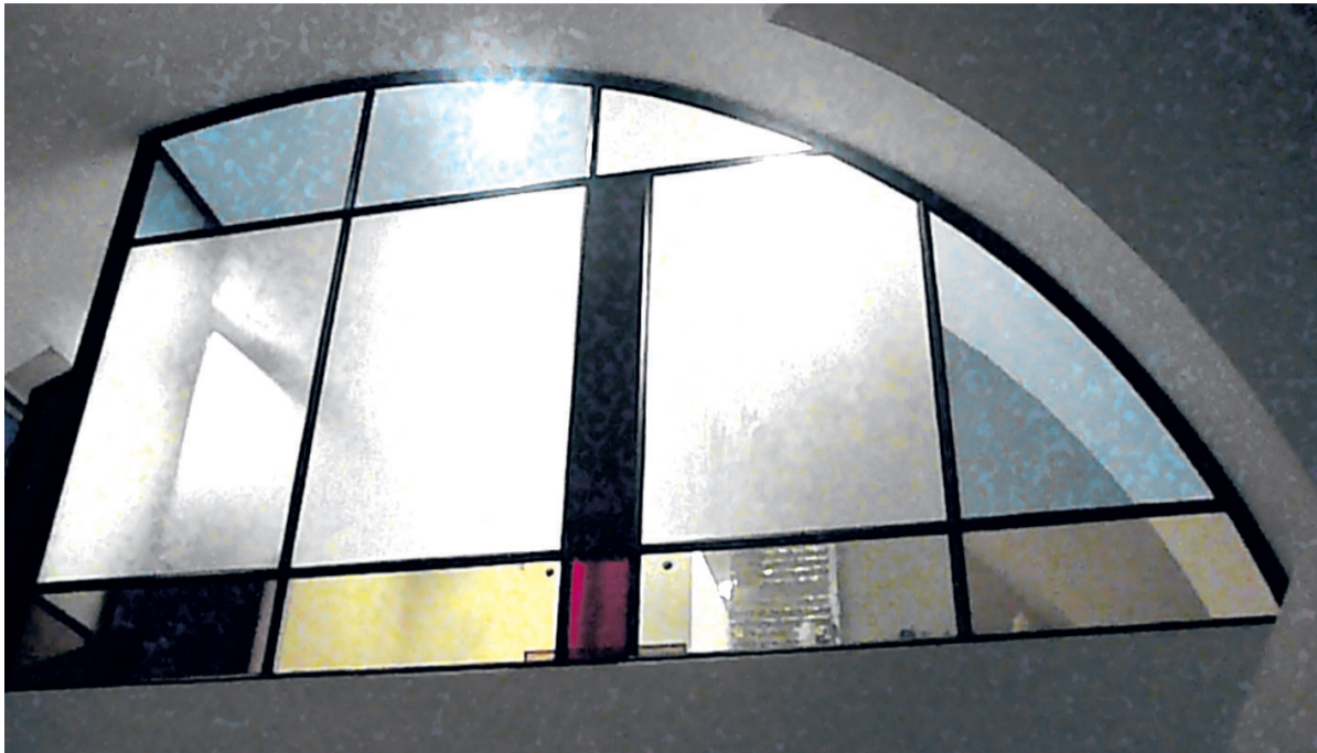
In het interieur van de voormalige Eben Haëzkerker zijn rond gebogen profielen toegepast. De 32 millimeter dunne stalen profielen zijn voorzien van enkel glas. Foto: Different Windows
